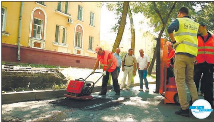
Еще одна наша методика — пропиточные составы для асфальтобетона. Это жидкости, которые внедряются на глубину до 1 см и возвращают битуму, входящему в состав асфальта, пластические свойства, что препятствует образованию ям, рассыханию и разрушению дорожного покрытия. Самая дорогая и тяжелая из наших пропиток стоит около 80 рублей за квадратный метр, но есть и более дешевые, легкие смеси.
